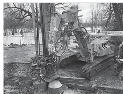
Рис. 1. Струйная цементация мерзлых грунтов в лотках
